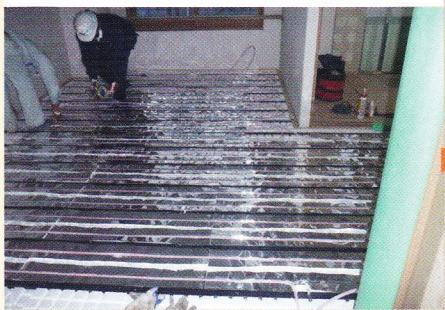
4. 高密度架橋ポリエチレン管配管
