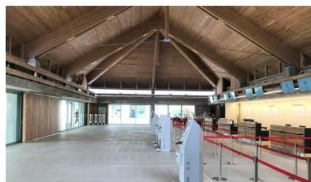
「ボラ ケア」は三菱地所グループが沖縄県宮古島市の下地島空港に建設する旅客ターミナル施設の建物のCLT(直交集成材)屋根の防腐防蟻剤として採用されました。これはアメリカカンザイシロアリに対する薬剤の違いによる防蟻性能比較実験、下地島空港建設現地において行った地下シロアリも含めた野外実験を元に採用されたものです。
