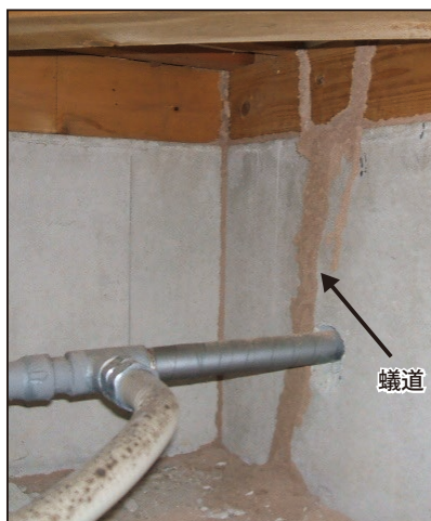
未処理の基礎コンクリート
