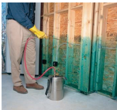
① 表面処理（現場施工）
